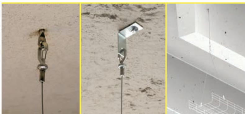
A medida que aumenta la popularidad de la construcción de concreto (hormigón), es cada vez más importante que todos los servicios necesarios puedan fijarse directamente a la estructura de concreto (hormigón). nVent CADDY ofrece distintos fijadores a estructura de concreto (hormigón) remachados para cables precortados o no precortados y así los instaladores pueden colgar todos los servicios necesarios directamente a la estructura.
