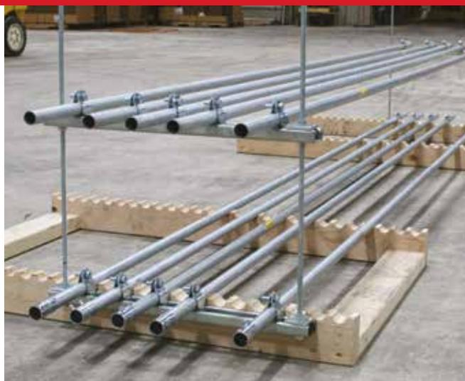
L'interasse tra i tubi o conduits sul profilo di supporto deve essere costante in modo da potersi agevolmente connettere tra le varie sezioni. Raccomandiamo di usare dime in legno prespaziate. Possono facilmente essere realizzate in cantiere con materiale in legno e personalizzate per ogni esigenza.
