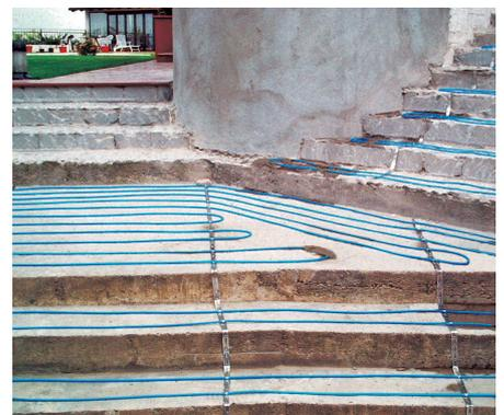
Modèle de flexibilité, le EM4-CW se pose aisément sur les surfaces de forme irrégulière. Une excellente solution pour les escaliers de secours.
