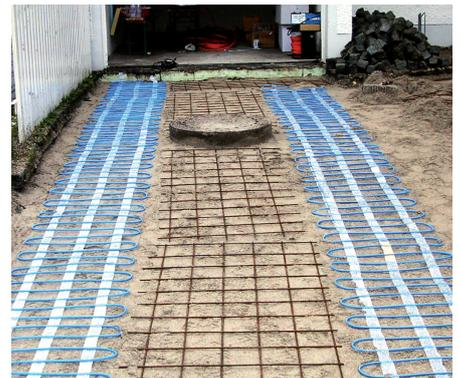
Rapidité et simplicité d'installation maximale! EM2-CM est la solution idéale pour le chauffage des accès carrossés et des trottoirs en béton ou pavés.
