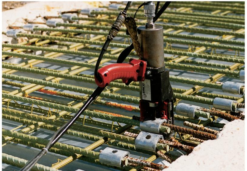
ACI318-02 Tipo 1, con una resistencia del empalme mínima del 125% de la resistencia nominal. El sistema de conexión puede también desarrollar el 120% de la resistencia nominal según CSA A23.3-1994 (utilizando barras de refuerzo G30.18-1992 grado 400 MPa).
