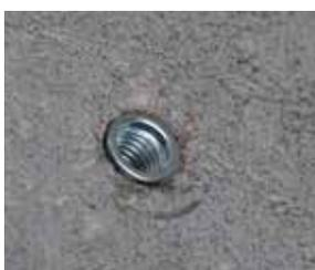
Fijador a orificio roscado en estructura para refuerzo sísmico liviano en ramal
