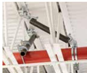
Fijador a viga tipo joist
