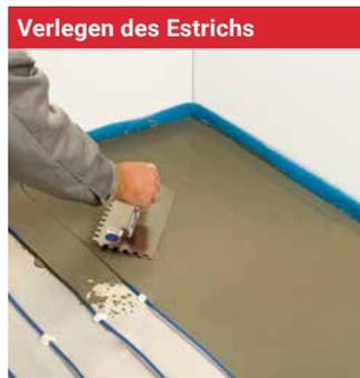
Bringen Sie den Estrich vorsichtig ein, ohne das Heizkabel zu beschädigen. Lassen Sie den Estrich entsprechend den Herstelleranweisungen aushärten.
