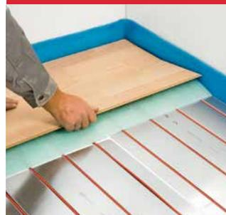
Legen Sie auf die Reflecta-Platten eine Unterlage/Vlies für Holzböden, auf der Sie dann den neuen Holz- oder Laminatboden entsprechend den Herstelleranleitungen verlegen.
