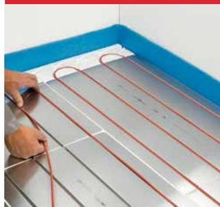
Drücken Sie das T2Red-Heizband in die Verlegeluten. Die gewünschte Wärmeleistung ergibt sich aus den Abständen des Heizbands (100, 200 oder 300 mm).
