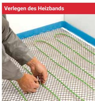
Bestimmen Sie zuerst die zu beheizenden Flächen, bevor Sie mit der Installation des Heizbands beginnen. Stimmen Sie diese mit dem Planer/ Architekten und Estrichleger ab. Befestigen Sie das Heizband unter Einhaltung der gewünschten Heizbandabstände auf einem Metallgewebe (mit KBL-10-Kabelbindern).
