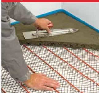
Bringen Sie den Estrich vorsichtig ein, ohne das Heizband dabei zu beschädigen. Lassen Sie den Estrich entsprechend den Herstelleranweisungen aushärten. Je nach Estrichart kann dieser Vorgang von 7 (Anhydritestrich) bis zu 21 Tagen (Zementestrich) dauern. Das erstmalige Auf- und Abheizen des Estrichs muss mit dem Baustoff-Lieferanten abgestimmt und dokumentiert werden.
