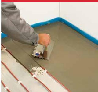
Tragen Sie vorsichtig eine gleichmäßige Schicht Ausgleichsmasse auf dem Heizband auf. Lassen Sie den Estrich entsprechend den Herstelleranweisungen aushärten.
