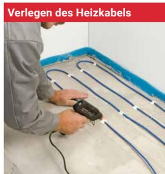
Tragen Sie eine Schicht Haftgrundierung auf. Befestigen Sie das Heizkabel (z. B. mit einer Heißklebepistole) auf dem sauberen Fußboden.
