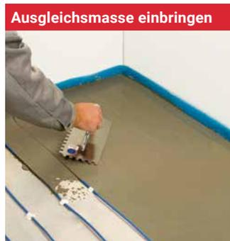
Tragen Sie vorsichtig eine gleichmäßige Schicht Ausgleichsmasse auf dem Heizkabel auf. Lassen Sie den Estrich entsprechend den Herstelleranweisungen aushärten.
