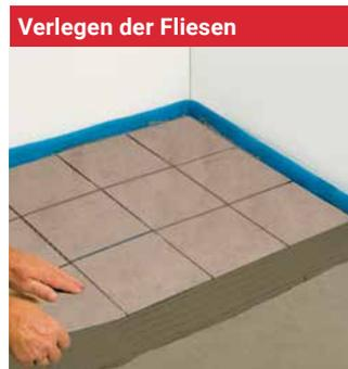
Verteilen Sie den Fliesenkleber, verlegen und verfugen Sie dann die Fliesen. In Nassbereichen muss vor dem Fliesenkleber erst eine wasserdichte Beschichtung aufgetragen werden.
