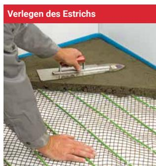
Bringen Sie den Estrich vorsichtig ein, ohne das Heizband dabei zu beschädigen. Lassen Sie den Estrich entsprechend den Herstelleranweisungen aushärten. Je nach Estrichart kann dieser Vorgang von 7 (Anhydritestrich) bis zu 21 Tagen (Zementestrich) dauern. Das erstmalige Auf- und Abheizen des Estrichs muss mit dem Baustoff-Lieferanten abgestimmt und dokumentiert werden.
