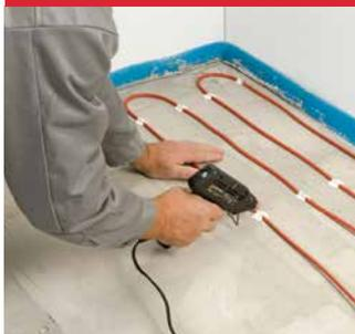
Säubern Sie den Boden. Tragen Sie eine Schicht Haftgrundierung auf. Befestigen Sie das Heizband (z. B. mit einer Heißklebepistole) auf dem Fußboden.
