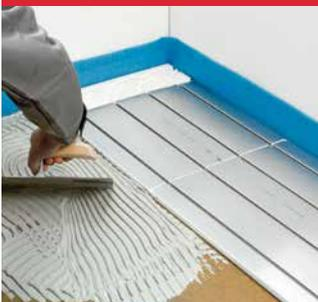
Geben Sie Reflecta-Kleber A-Fix auf den Untergrund (oder schrauben Sie die Platte mit jeweils 15 Schrauben auf einem Holzuntergrund fest). Legen Sie die Reflecta-Platten in den verteilten Kleber und lassen diesen aushärten.
