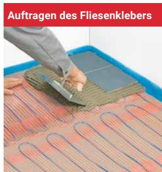
Tragen Sie den Fliesenkleber direkt auf die QuickNet-Matte auf. In Nassbereichen muss vor dem Fliesenkleber erst eine Ausgleichsmasse und eine wasserdichte Beschichtung aufgetragen werden.
