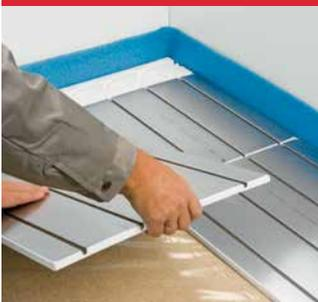
Verlegen Sie die Reflecta-Platten (Verschrauben oder Ankleben ist nicht nötig) auf dem Untergrund.
