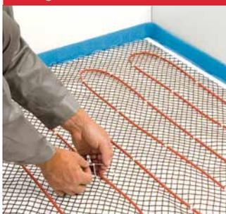
Bestimmen Sie zuerst die zu beheizenden Flächen, bevor Sie mit der Installation des Heizbands beginnen. Stimmen Sie diese mit dem Planer/Architekten und Estrichleger ab. Befestigen Sie das Heizband unter Einhaltung der gewünschten Heizbandabstände auf einem Metallgewebe (mit KBL-10-Kabelbindern).
