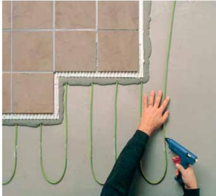
Das flexible Fußbodenheizkabel ist für die direkte Verlegung in einer Ausgleichsmasse unter sehr gut gedämmten Böden geeignet.
