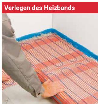
Säubern Sie den Boden. Tragen Sie eine Schicht Haftgrundierung auf. Rollen Sie die Heizmatte auf dem Boden aus.
