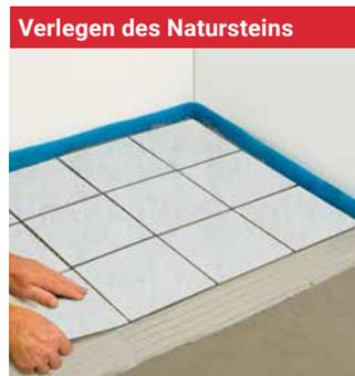
Verteilen Sie den Natursteinkleber, verlegen und verfugen Sie dann den Naturstein. In Nassbereichen muss vor dem Natursteinkleber erst eine wasserdichte Beschichtung aufgetragen werden.
